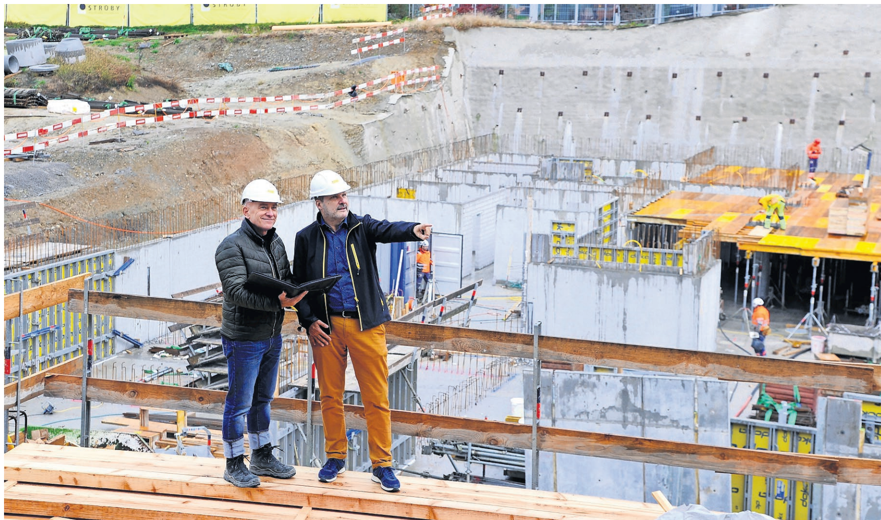
Daniel Hofstetter (links) und Roland Stadelmann von den Strüby Unternehmen besprechen sich über die ersten Häuser. In der Grube wird die Garage erstellt. Foto Daniel Schmuki
