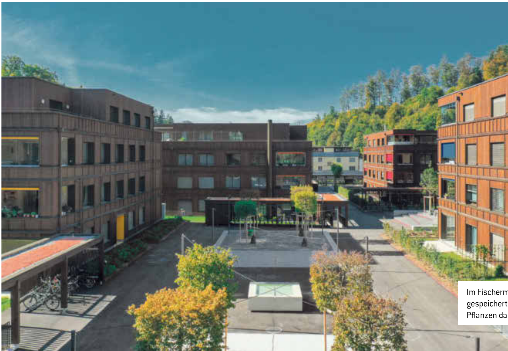
Bild: Strüby Unternehmungen
