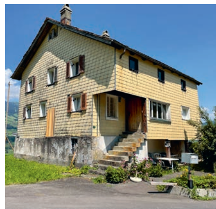
Das ehemalige Bauernhaus kurz vor Beginn der Umbau- und Sanierungsarbeiten.
