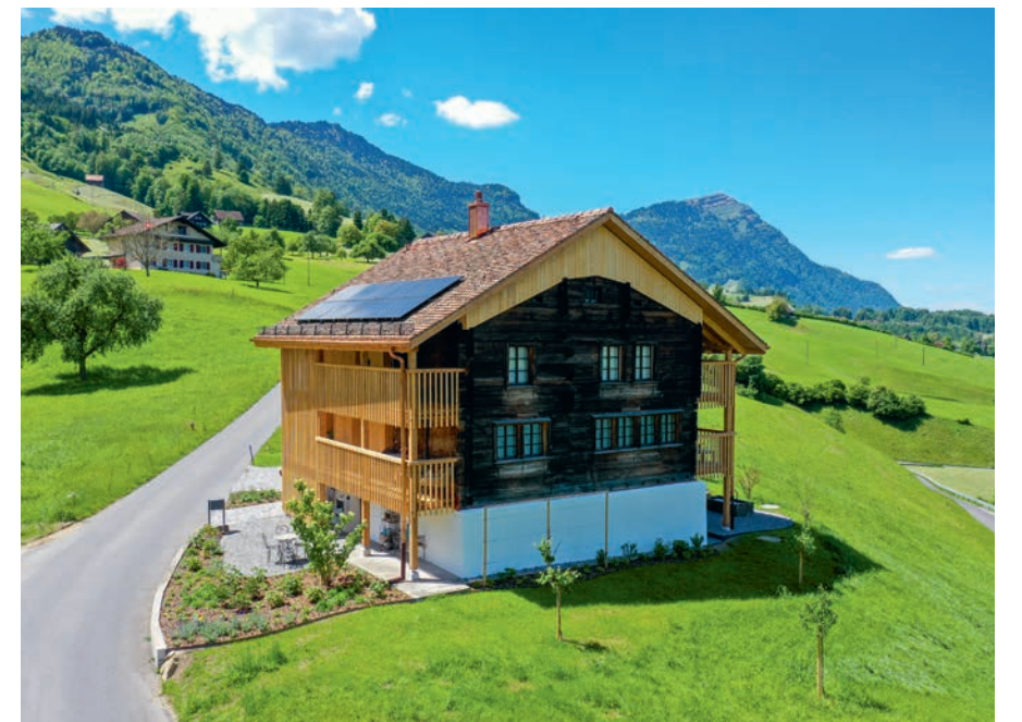
Auf der Rückseite zeigt das Blockhaus von 1492/93 seine bauliche Geschichte.
