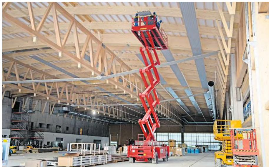
Die gigantische Halle nimmt Tag für Tag mehr Gestalt an.
