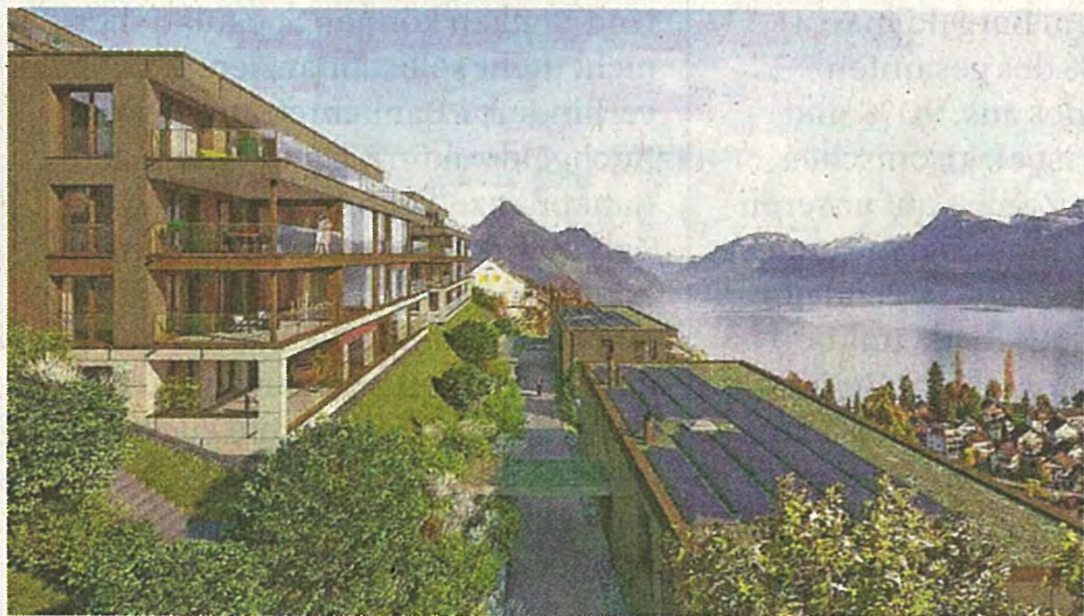
Die Seebner Firma Strüby hat in Ennetbürgen elf Mehrfamilienhäuser mit 67 Eigentumswohnungen erstellt. Bild: PD
