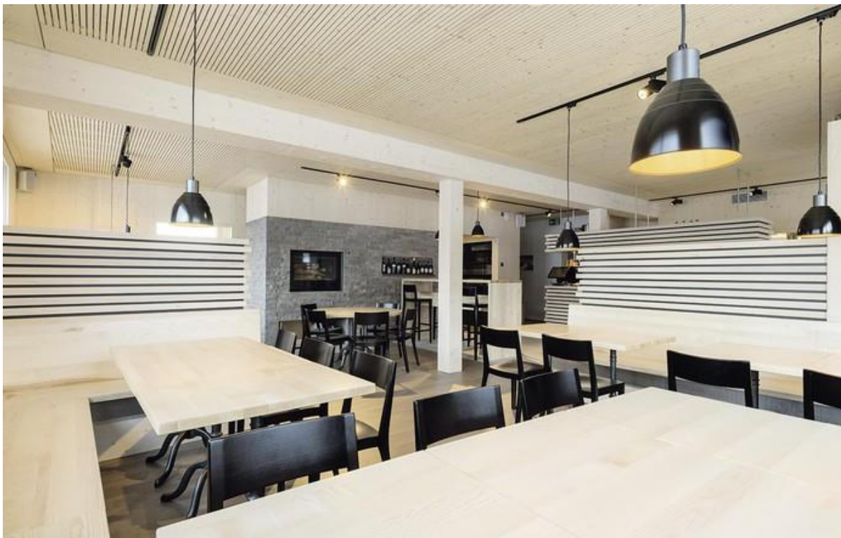
Das Restaurant der Hütte ist in zwei Gasträume unterteilt. Die Deckenuntersicht hat man dort in weiß geölter Tanne ausgeführt und für eine verbesserte Akustik zum Teil fein gerippt. © Zuerrer Design
