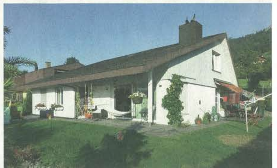
Vorher: Durch das Schrägdach war im ersten Stock ein grosses Platzpotenzial ungenutzt.
