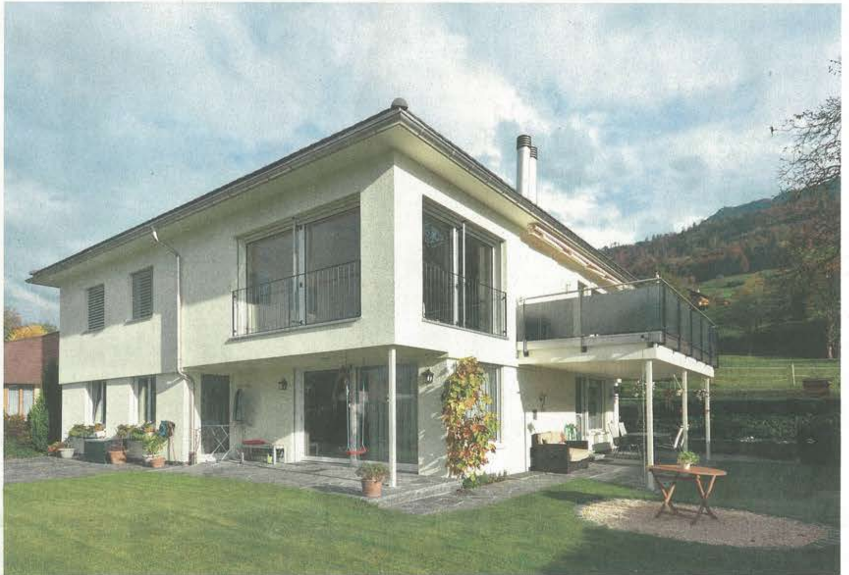
Nachher: Durch die Aufstockung ist in der oberen Etage grosszügig neuer Wohnraum geschaffen worden. Ein besonderer Pluspunkt der Neugestaltung: die grossen Schiebefenster in der Ecke, der geräumige Balkon und die darunterliegende, überdachte Veranda.
