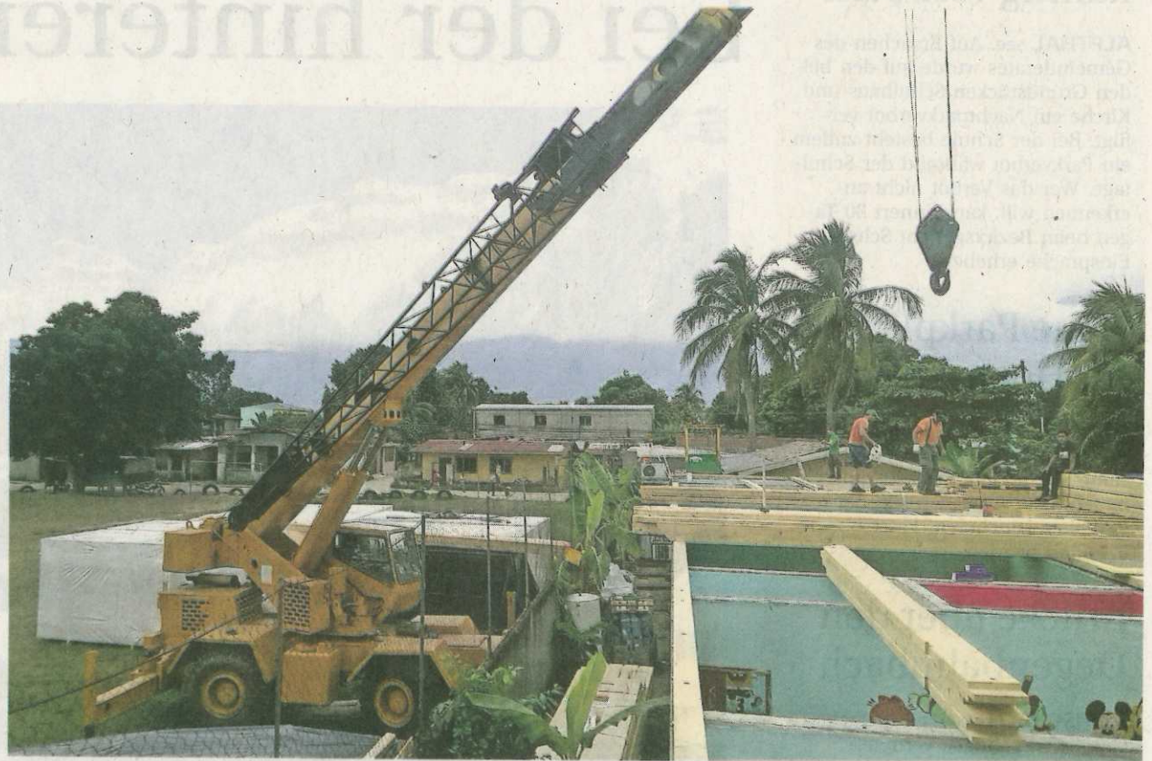
Es handelte sich um eine Aufstockung. Die neuen Räume wurden auf das bestehende Gebäude aufgesetzt. Um die Elemente zu verarbeiten, wurde vor Ort ein Kran gemietet.
